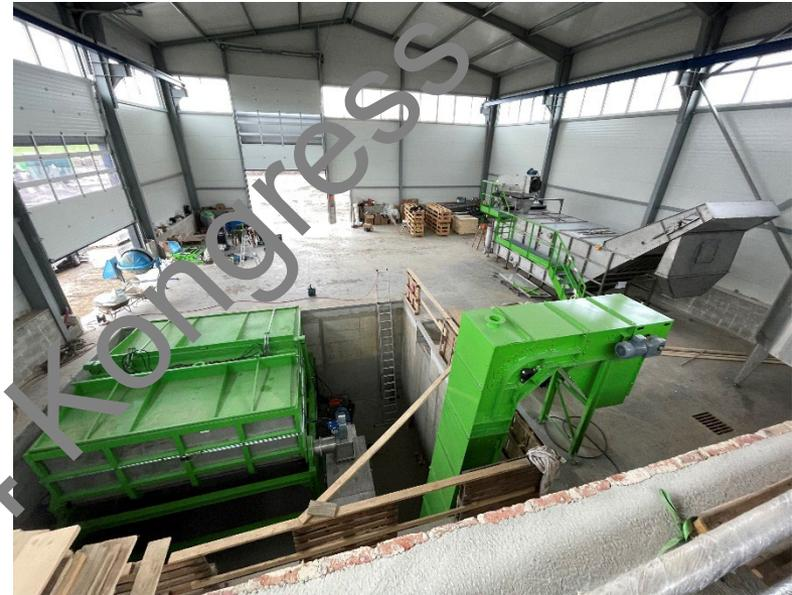
Die **OWT Fill + Mill** ist eine Kombination bestehend aus einem Aufgabebunker und einer Mühle. Die Einheit wird unterirdisch platziert, um eine direkte Beladung vom Sammelfahrzeug in den Bunker zu gewährleisten. Ein Förderband transportiert die Leichtfraktion/RDF hinauf zum Entladeniveau.
