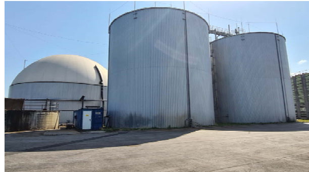
Abfallvergärungsanlage Bruck an der Leitha
